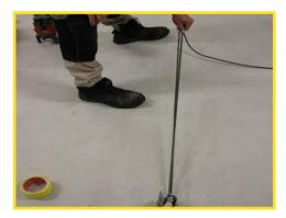
Abkleben der Fugen und Eintrag des Primers und der Fugen-Dichtmasse
