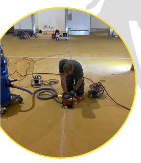
Aus diesem Grund nutzen wir heute keine Schlagschnur mehr, um die Markierung für den Schnitt der Fuge auszuführen.
