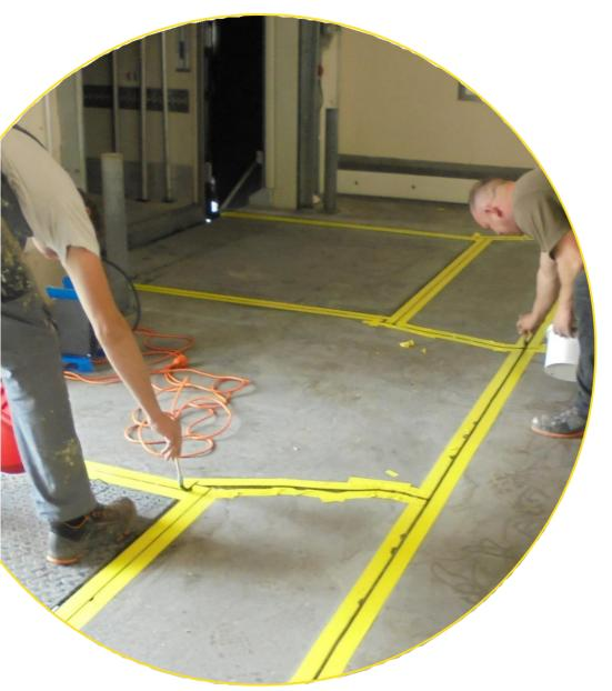
Bevor wir die Dichtungsmasse in die Fugen einbrigen, muss noch der Primer, ähnlich einem Voranstrich oder eines Tiefgrunds für die bessere Haftung der Fugendichtmasse eingebracht werden.
