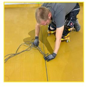
Zum Abfangen etwaiger Bewegungen oder Spannungen wird nun zunächst der sogennante Rundschlauch eingesetzt.
